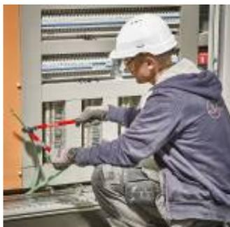
Кабелерезы или Кабельные ножницы-кусачки предназначены для обрезания изолированных алюминиевых и медных кабелей. Ножи из термообработанной легированной стали, полученные объемной штамповкой на падающем молоте, обрезают кабель с минимальной деформацией внутренних проводов. Имеют изолированные стекловолокном рукоятки и резиновые ручки.
